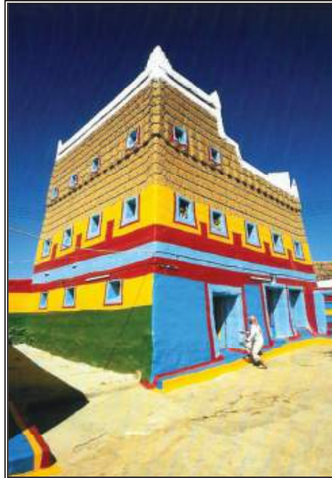
شكل (٣١) منزل شعبي يظهر حرفة الطلاء وأنها ليست مجرد حرفة بل فن مستقل (المنزل بالمنطقة الجنوبية).
